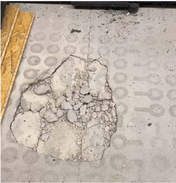
Abbildung 1: Estrichkonstruktion 2 Monate alt unter Freigewichtsbereich
