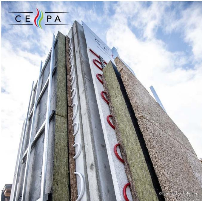
**Abbildung 5:** Die Fassade als Energiespeicher – CEPA (Quelle TOWERN 3000)
