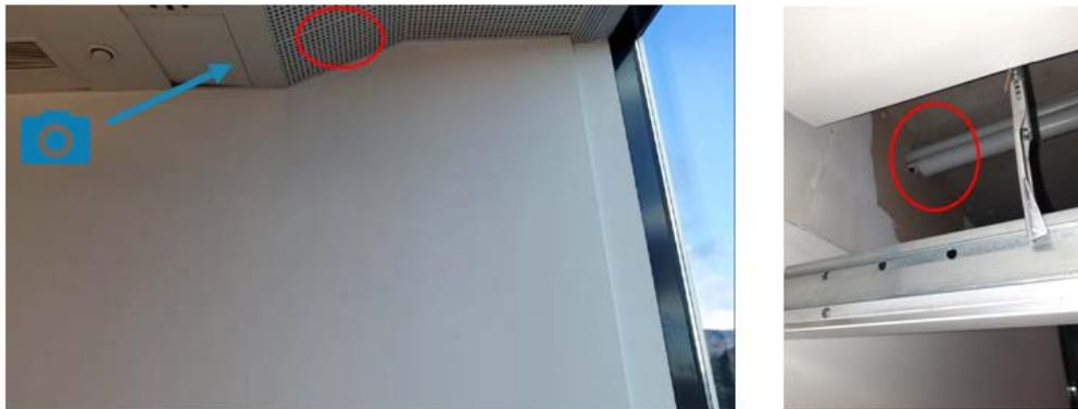
**Abbildung 23:** Ursache aufgrund nicht isolierter Durchführung von Elektroinstallationsrohren im Bereich der perforierten Decke.
