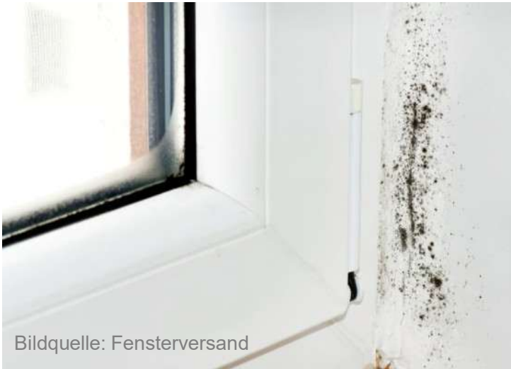
Feuchteschaden nach Fenstersanierung
