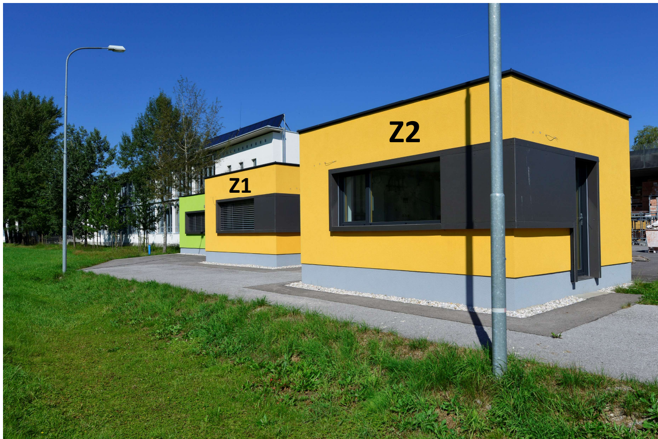
Ziegelkuben in Gelb (vor Projektstart), Südost-Ansicht ©ZAB
