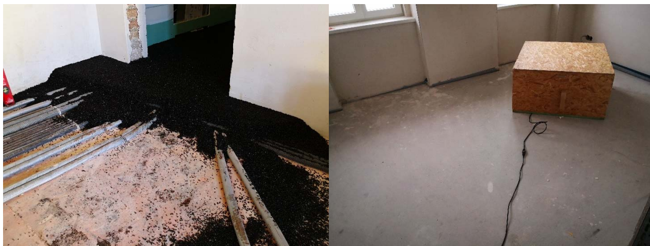
Abbildung 6: Einbringen der PUR-gebundenen Schüttung (links); Trittschallmessung nach Fertigstellung des Estrichs (rechts);
