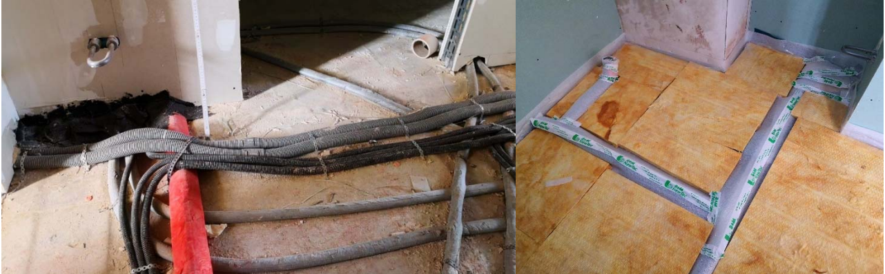
Abbildung 2: Leitungskreuzungen im Fußbodenaufbau vor dem Einbringen der Schüttung; die Höhe im Bereich der Kreuzung beträgt ca. 11 cm (links); aufgrund der zu geringen Schüttungshöhe durchdringen die Abflussrohre die Trittschalldämmung, daher werden sie mit einer dünnen Schaumstoffolie abgedeckt (rechts);
