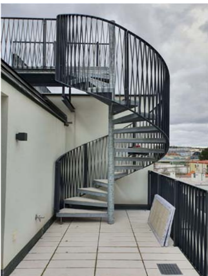
Abbildung 4: Stahl-Wendeltreppe als Erschließungstreppe mit angrenzenden Wohneinheiten
