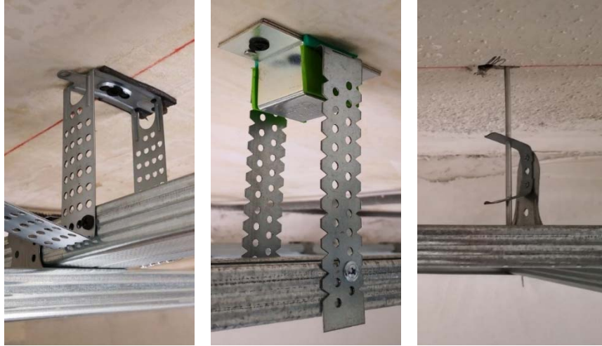
Abbildung 7: Untersuchte Typen von Abhängern; Direktabhänger (links), Direktabhänger mit Sylomerlager (Mitte), Ösendrahtabhänger (rechts)
