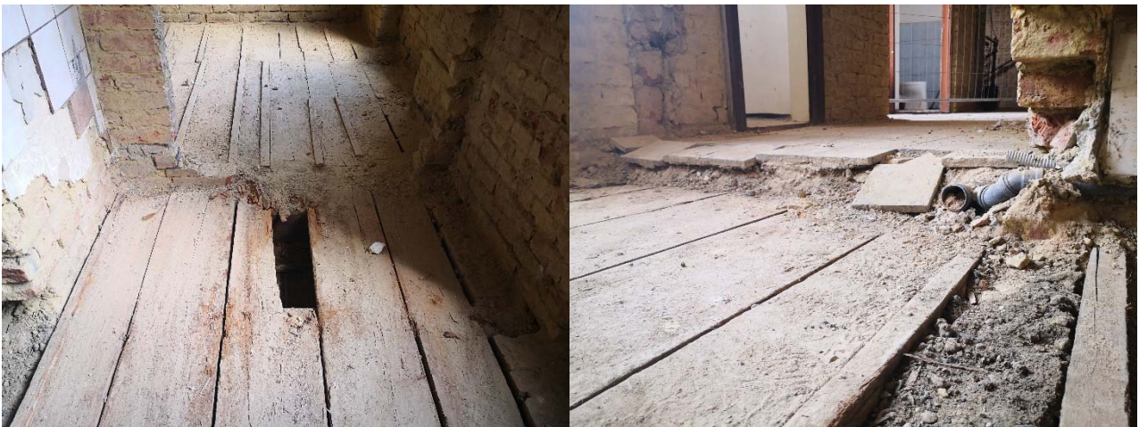
Abbildung 1: Rohdecke mit schadhafter Deckschalung (links); Fußbodenaufbau des Bestands im Gangbereich (rechts)
