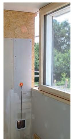
Kein Schimmel, weder an den Innenoberflächen noch hinter den Dämmplatten (Abb. 8 a).
